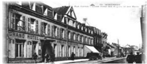
Grand Hôtel des Anglais et des Bains de 1914 à 1919 Hôpital N°5 Croix Rouge Britannique.
